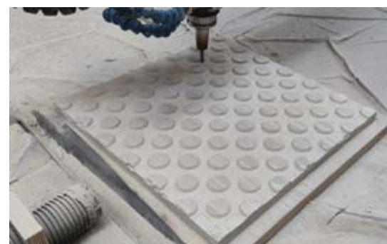
➤ Finale Fräsbearbeitung des extrudierten Betons
