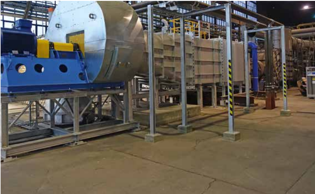
Abwärmenutzung aus einem Stahlwerk für das Fernwärmenetz in Hennigsdorf
