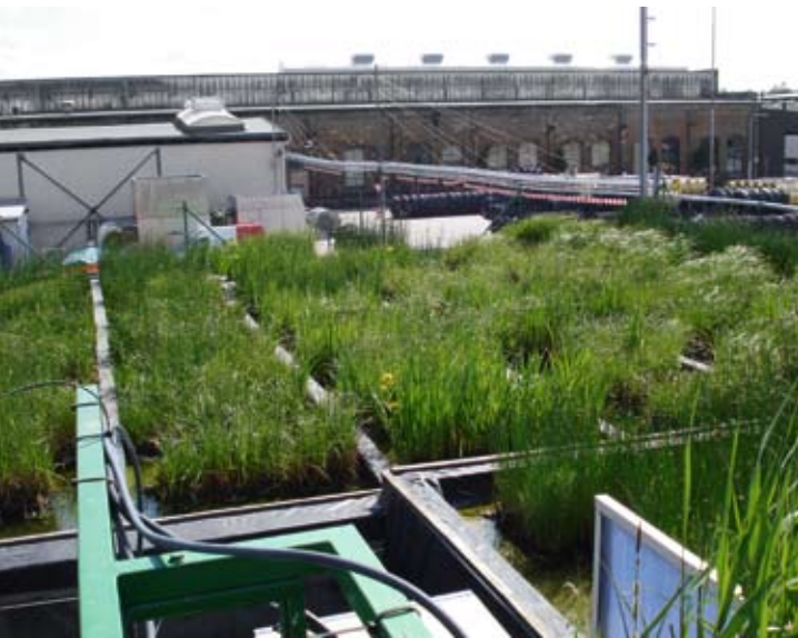
Dachpflanzenkläranlage bei John Deere in Mannheim
