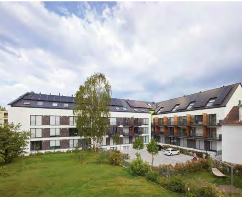
Außenansichten von campoV zeigen die Vollbelegung der Dachflächen in allen Himmelsrichtungen mit PV-Modulen. © Roland Halbe
