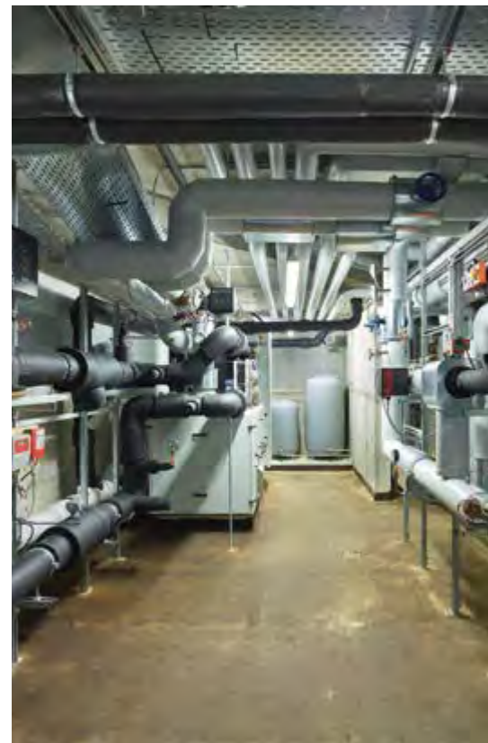
Heizungszentrale mit Erdwärmepumpe und detaillierter Erfassung von Messdaten für ein ausführliches technisches Monitoring © Roland Halbe
