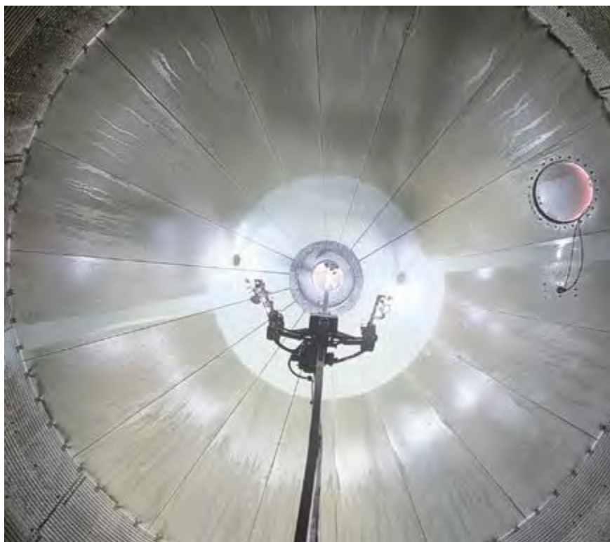
➤ Das Innere eines Silos mit Zugangsluke (rechts) und Zweiarm-Reinigungsroboter
