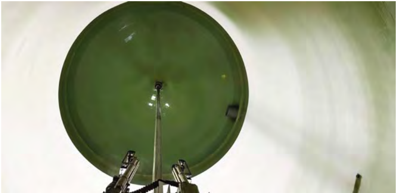
➤ Mit Robotertechnik gereinigtes Silo
