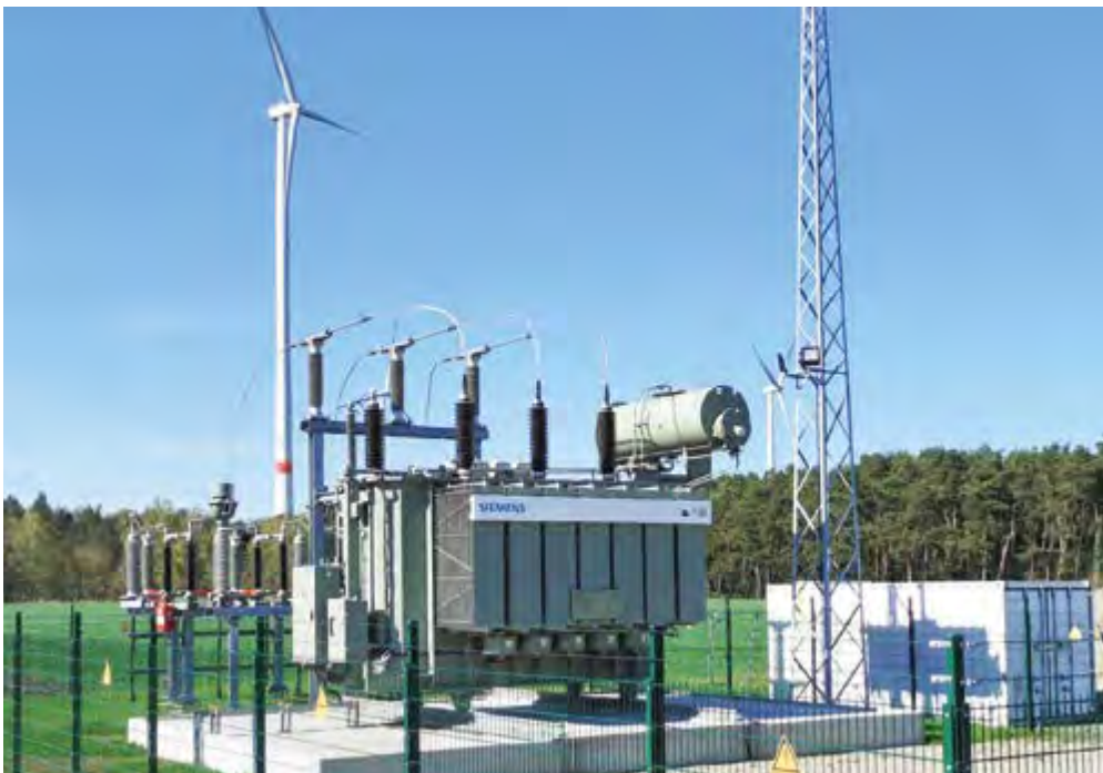
Leistungstransformator für die Netzanbindung eines Windparks © Prof. Dr.-Ing. Stefan Tenbohlen
