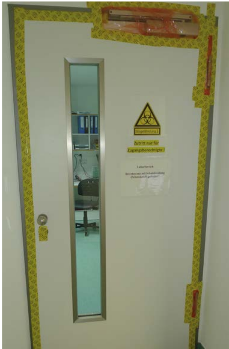
Abklebung der Eingangstür ins Labor zur Vorbereitung des Dichtheitstests.
