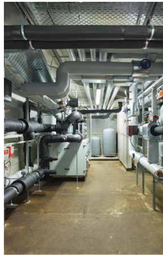
Heizungszentrale mit Erdwärmepumpe und detaillierter Erfassung von Messdaten für ein ausführliches technisches Monitoring © Roland Halbe
