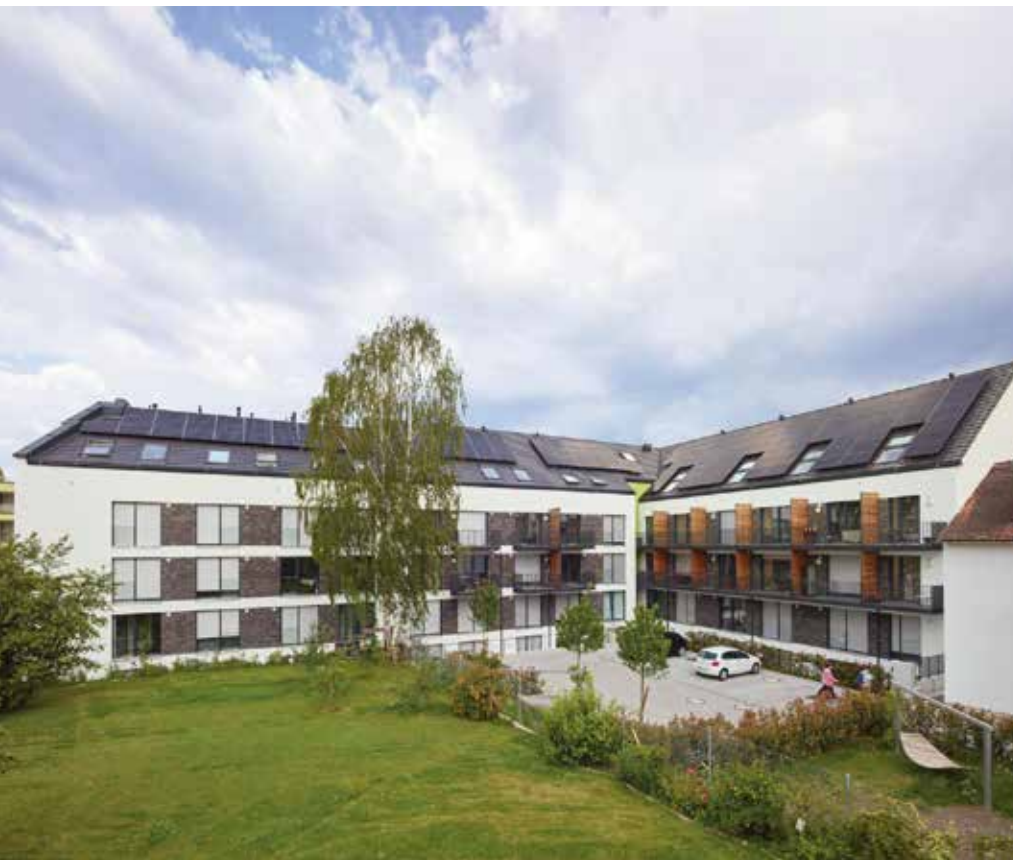
Außenansichten von campoV zeigen die Vollbelegung der Dachflächen in allen Himmelsrichtungen mit PV-Modulen. © Roland Halbe
